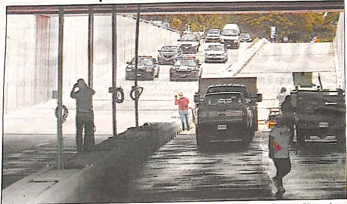
Los trabajos de bombeo de 4 millones de litros cúbicos de agua en el lugar, se hicieron con cuatro bombas sumergibles, que fueron "tronando" debido a que las mantuvieron funcionando sin descanso. (Fotos Enrique Osomo)
