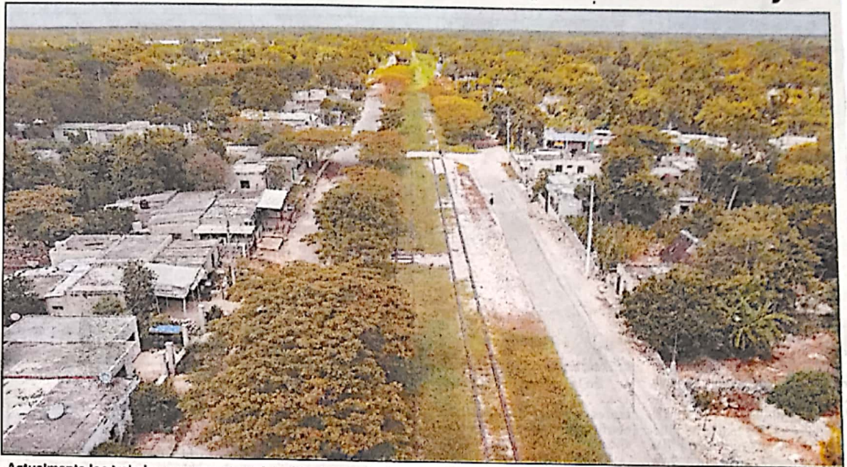
Actualmente los trabajos se encuentran detenidos hasta que haya solución para que la línea férrea no afecte las casas del municipio.
