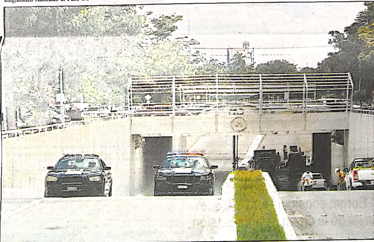
Hasta el momento se desconoce cuándo se abrirá la circulación en el carril de Sur a Norte, ya que será hasta la siguiente semana cuando se terminen los trabajos provisionales de rehabilitación del distribuidor vial.
